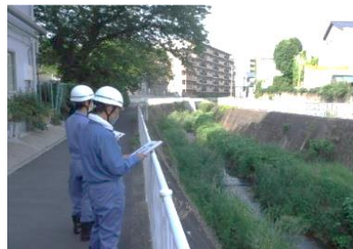
土砂堆積調査 （目視点検）
