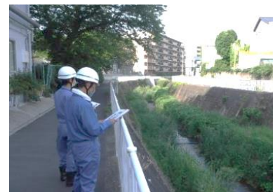
土砂堆積調査 （目視点検）
